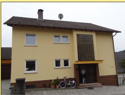
Abb. 12: Typisches Wohngebäude aus den 70er Jahren mit Glasbausteinfassade
