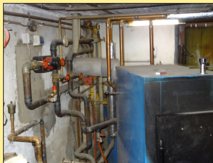
Abb. 13: Ungedämmte Heizungsleitungen
