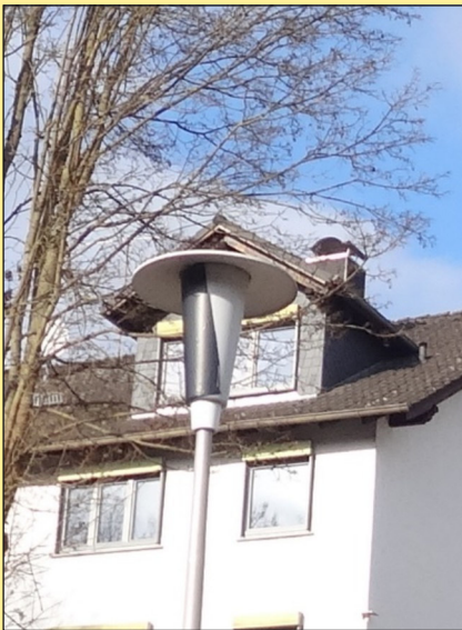
Abb. 7: Abgeklebte Pilzleuchte im Ortsteil Hain im Spessart
